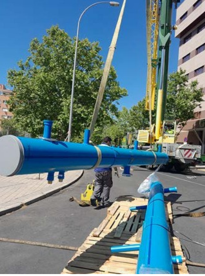
Las Tablas, Madrid'de bulunan bir otelin klima tesisatı için iki adet 355 mm çapında PP-R NIRON kollektör imalatı.
