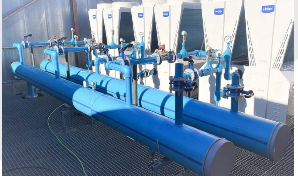
Las Tablas, Madrid'de bulunan bir otelin klima tesisatı için iki adet 355 mm çapında PP-R NIRON kollektör imalatı.
