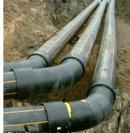
Elektrofüzyon birleştirme örneği
