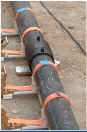
Elektrofüzyon birleştirme örneği
