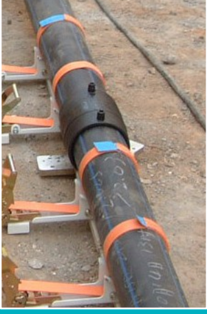
Elektrofüzyon birleştirme örneği
